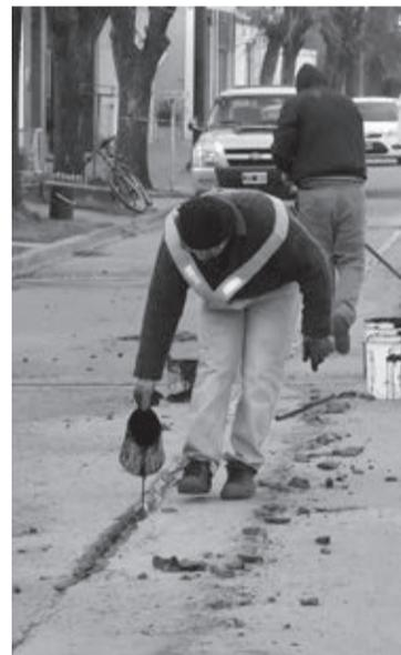
La aplicación en frío minimiza el peligro de los operarios y no genera inconvenientes a los vecinos ya que la brea no necesita someterse a la acción del calor. ■
