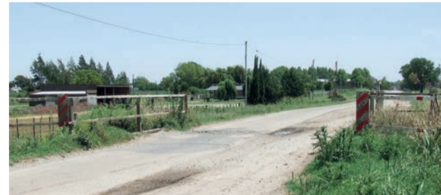
Un puente que necesita ser ampliado.
