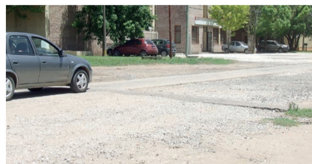
Lomo de burro sin señalización e incompleto.
