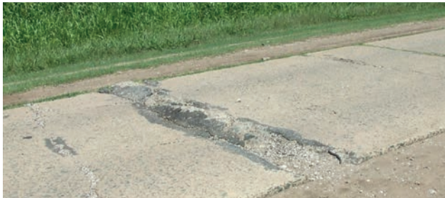
Lamentable estado de una avenida de acceso.
