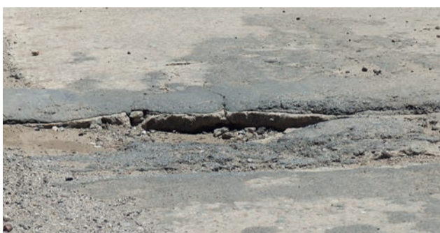
Abandono en el puente angosto
