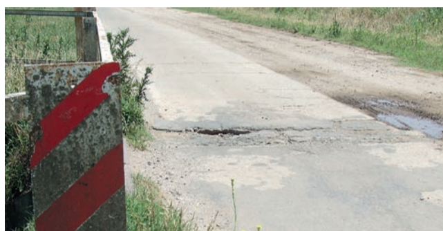
Señalización muy antigua y un bache peligroso.
