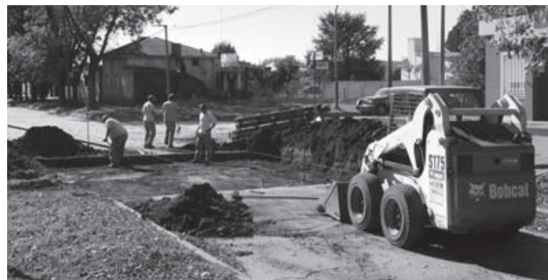
Avenida 50 y Calle 65. Se realizó un importante trabajo de hormigonado de la superficie.
